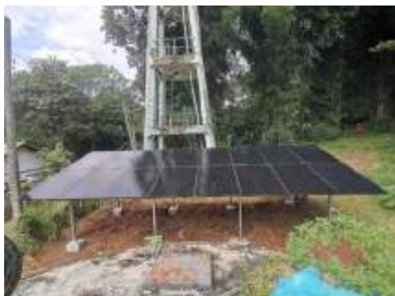
รูปที่ 5.6.3-5 การติดตั้ง และทดสอบระบบผลิตไฟฟ้าพลังงานแสงอาทิตย์ ขนาด 5 kW ณ จุดที่ 2 ประปาหมู่บ้าน
