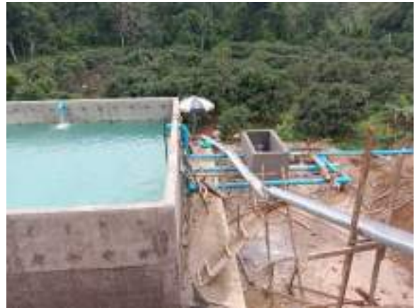
ก่อสร้างบ่อพักน้ำ สาย MP ความจุ 200 ลบ.ม. จำนวน 1 แห่ง
