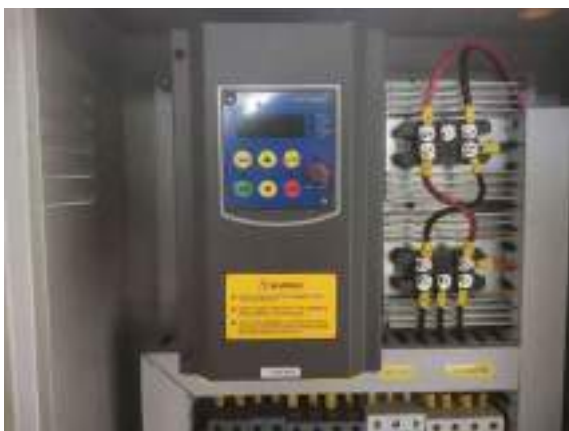
รูปที่ 5.6.3-4 การติดตั้ง และทดสอบระบบผลิตไฟฟ้าพลังงานแสงอาทิตย์ ขนาด 5 kW ณ จุดที่ 1 อาคารสูบน้ำ
