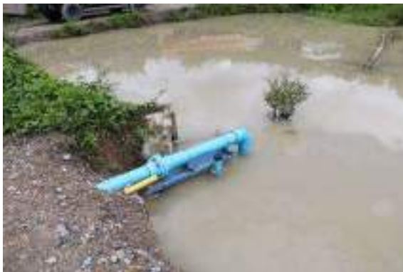
ท่อดูดน้ำจากบ่อเก็บกักตะกอนเข้าเครื่องบำบัด
