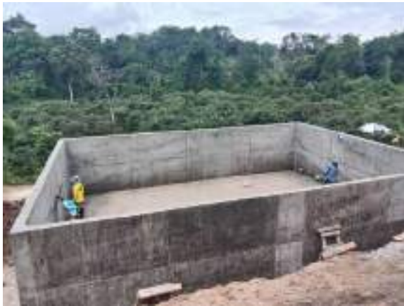
ก่อสร้างบ่อพักน้ำ สาย MP ความจุ 200 ลบ.ม. จำนวน 1 แห่ง
