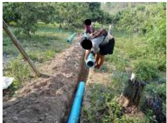
ก่อสร้างระบบส่งน้ำ สาย MP ความยาว 1,820 เมตร
