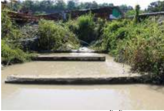
น้ำทิ้งจากอุโมงค์ไหลลงบ่อเก็บกักตะกอน
