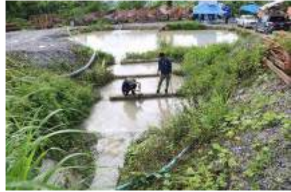
น้ำทิ้งจากอุโมงค์ไหลลงบ่อเก็บกักตะกอน
